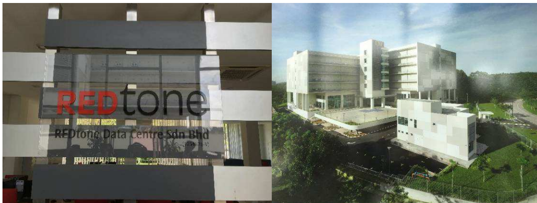
（データセンター全容）
